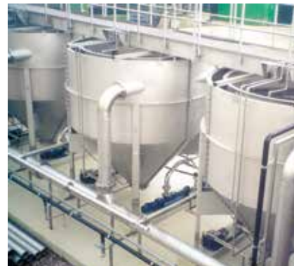
Par HUBER Kružna Zamka za Šljunak HRSF sistema.
