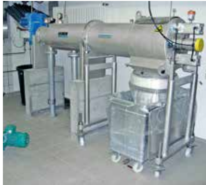
HUBER Čistač mulja STRAINPRESS® – kontinuirana separacija grubljeg materijala pod pritiskom.
