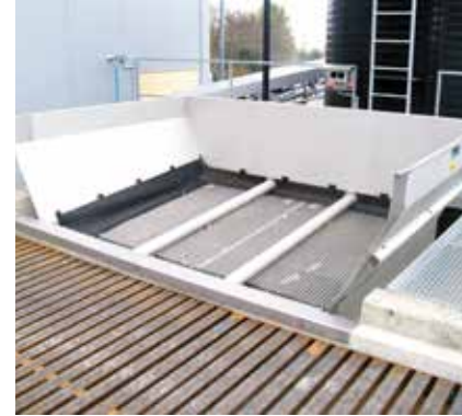
Robusna jedinica: jednostavno prihvatanje spoljne krupnozrnate materije.
