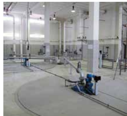
HUBER Vrtložna Komora za Šljunka VORMAX.
