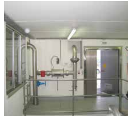
HUBER kompletni sistem aktivne prisilne ventilacije.
