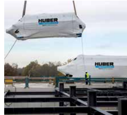
HUBER Disk Sušač RotaDry® tokom postavljanja na lokaciji.
