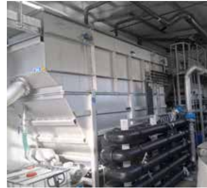
HUBER Postrojenje za flotaciju rastvorenog vazduha HDF za smanjenje masti i čvrstih materija pre indirektnog ispuštanja.
