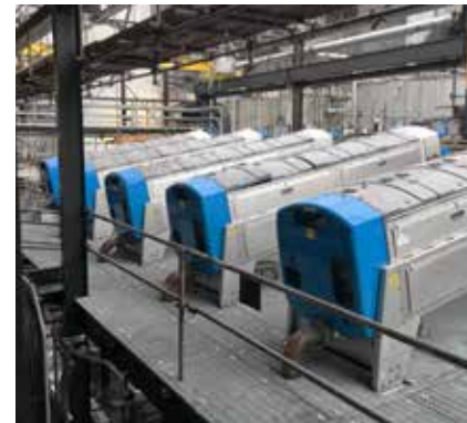
Odvodnjavanje mulja pomoću HUBER Pužne Prese Q-PRESS® 800.2.
