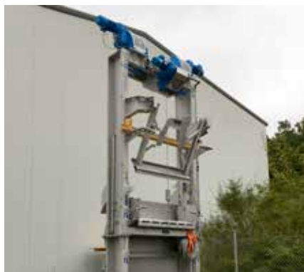
HUBER hvatač odpadaka sa rešetkom za pouzdano uklanjanje velikih grubih materijala.
