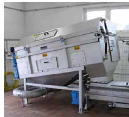
Pouzdati sistem za prihvatanje fekalnog mulja – HUBER postrojenje za prihvatanje mulja RoFAS.
