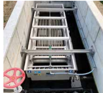
HUBER Izmenjivač Toplote RoWin C instaliran u betonskom kanalu.
