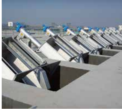
HUBER Fina Rešetka ROTAMAT® Ro1 za montažu u kanalima ili tankovima.
