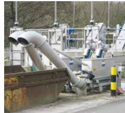
HUBER Presa za Pranje WAP® L sa sistemom napajanja kanalom za pranje: redundantan rad i optimalno odvodnjavanje rešetki.
