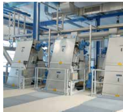
HUBER Rešetka sa više češljeva RakeMax® – čvrsti dizajn za pouzdan rad.
