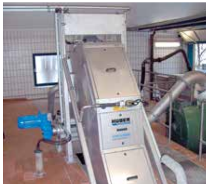
HUBER Fina Rešetka STEP SCREEN® SSF – originalni STEP SCREEN®.
