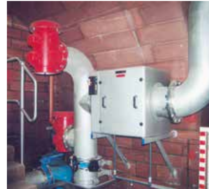
HUBER postrojenje za filtriranje vazduha za čistu pitku vodu.
