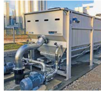
Flotacijska postrojenja HDF S za visoka opterećenja čvrstim česticama.
