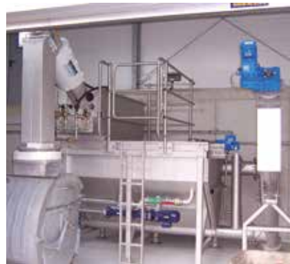
HUBER Kompletna Postrojenja ROTAMAT® Ro5 HD s hranilicom Hydro-Duct – kompaktna postrojenja za obradu otpadnih voda.
