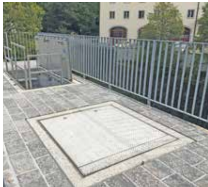
HUBER poklopac šahta SD7 koji podnosi opterećenje.
