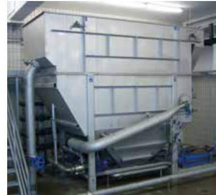
HUBER postrojenje za rastvorenu vazдушnu flotaciju (HDF) za separaciju čvrstih materija u industriji pića.
